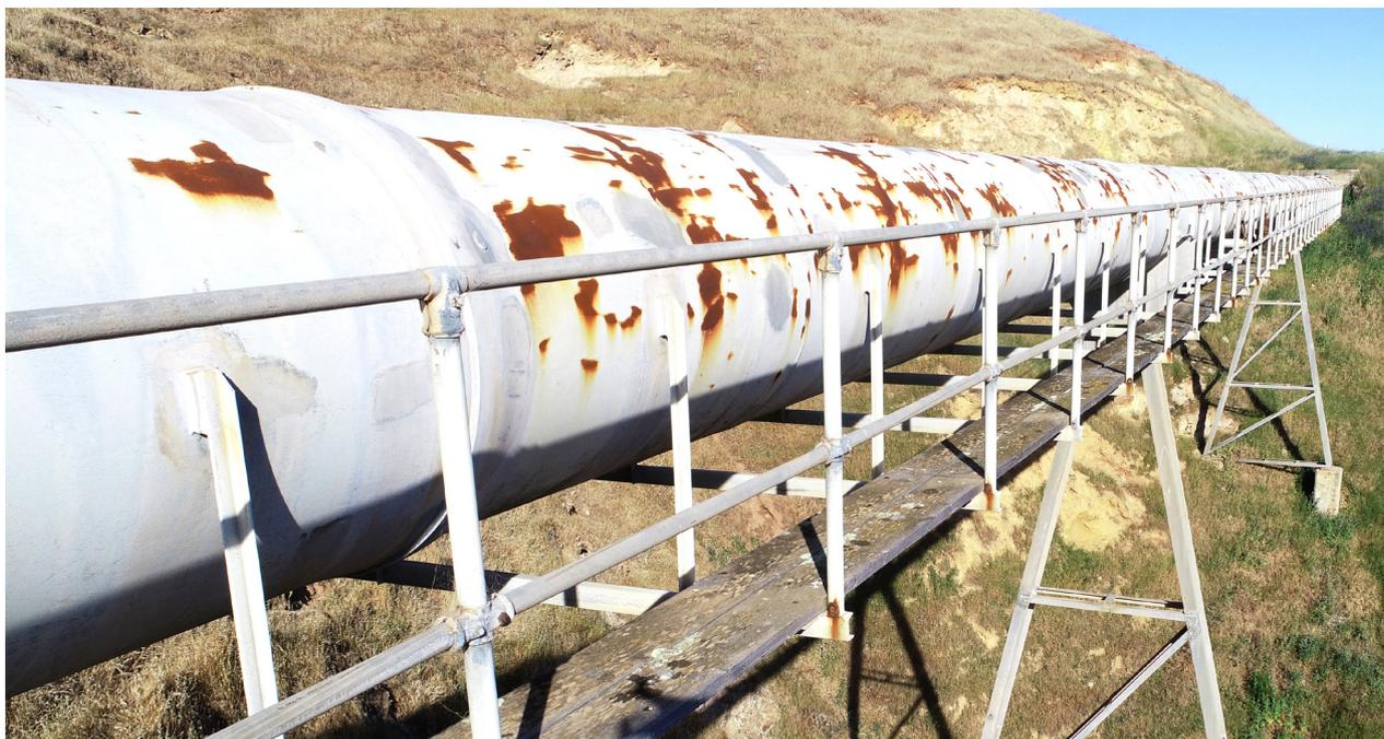
経年劣化による腐食や損傷はパイプラインを劣化させ、破裂の可能性を高めます。
