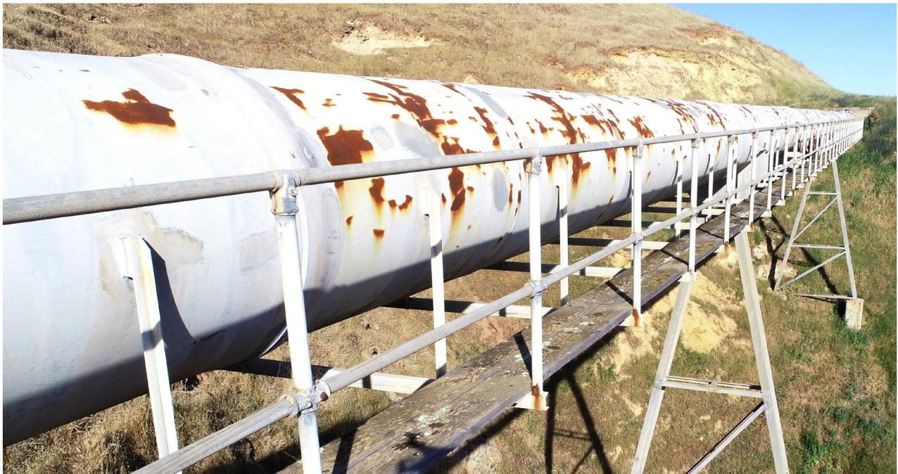
Korrosion und alterungsbedingte Schäden beeinträchtigen die Pipeline und erhöhen die Wahrscheinlichkeit von Rissen.
